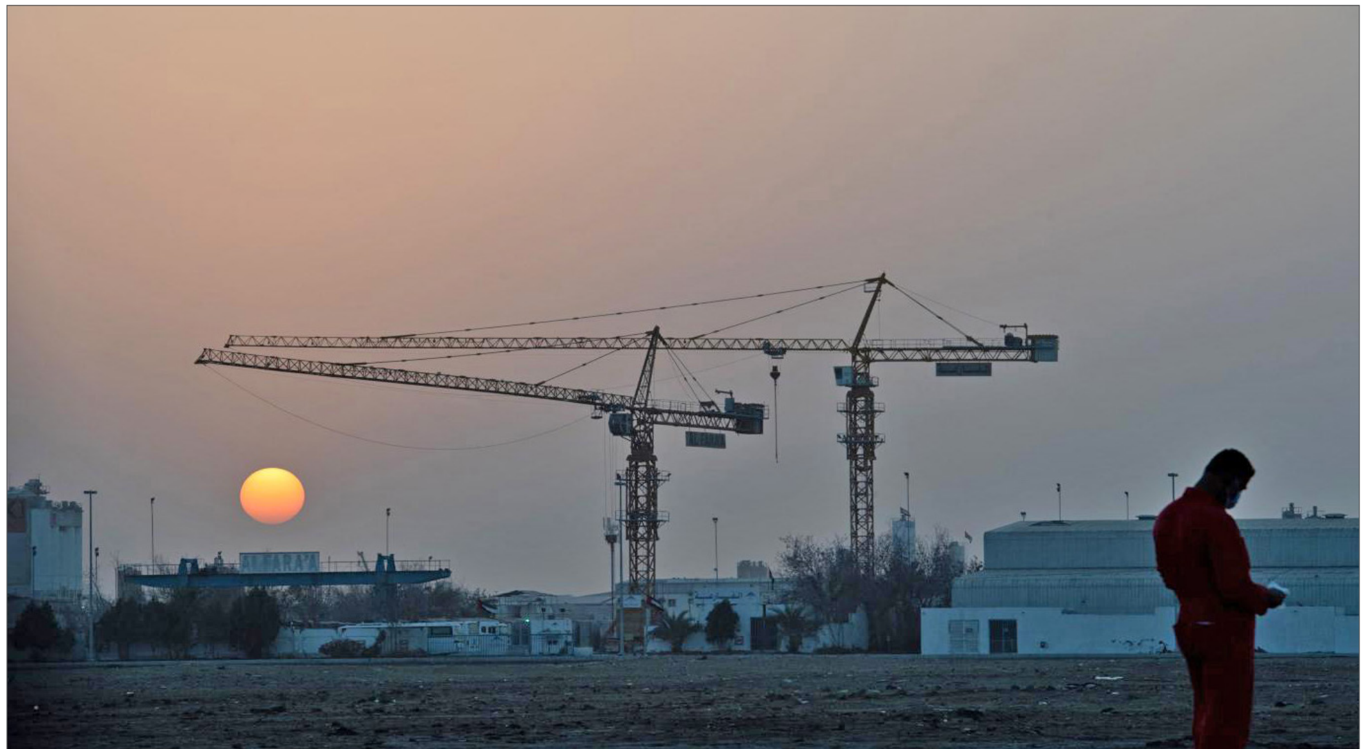
خزانات أدنوك في منطقة الإنشاءات الجديدة في مطار أبو ظبي الدولي
